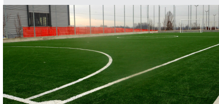
In fase di ultimazione il campo di calcetto
