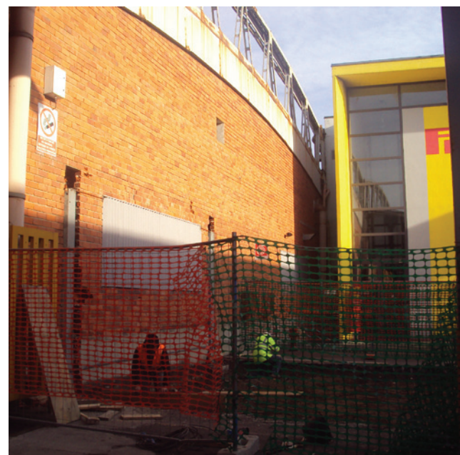
I lavori per il nuovo collegamento
